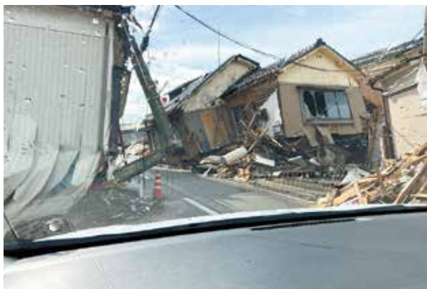
地震で折れ曲がった電柱のため道路が分断されている
