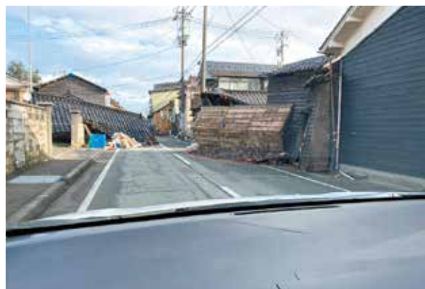
地震により倒壊した家のため道路が分断されている
