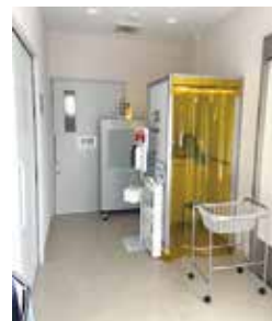
写真1 PCR 検体採取陰圧ブース W800 mm × W800 mm × H1900 mm
