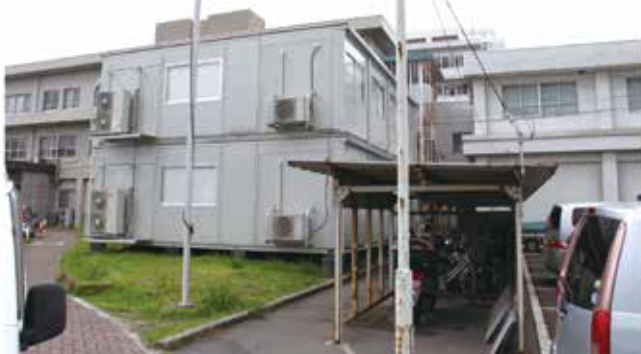
図1:電子カルテ導入基地の仮設プレハブ
